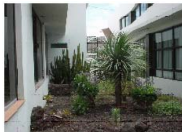
EDAR en el colegio Heidelberg. Gran Canaria. España
